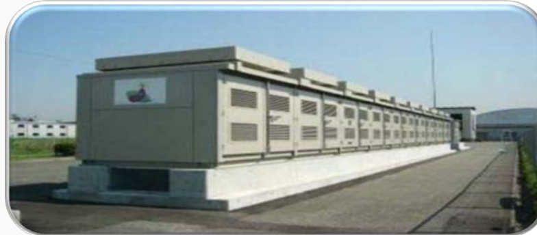
Аккумуляторные батареи большой энергоёмкости (АББЭ)
